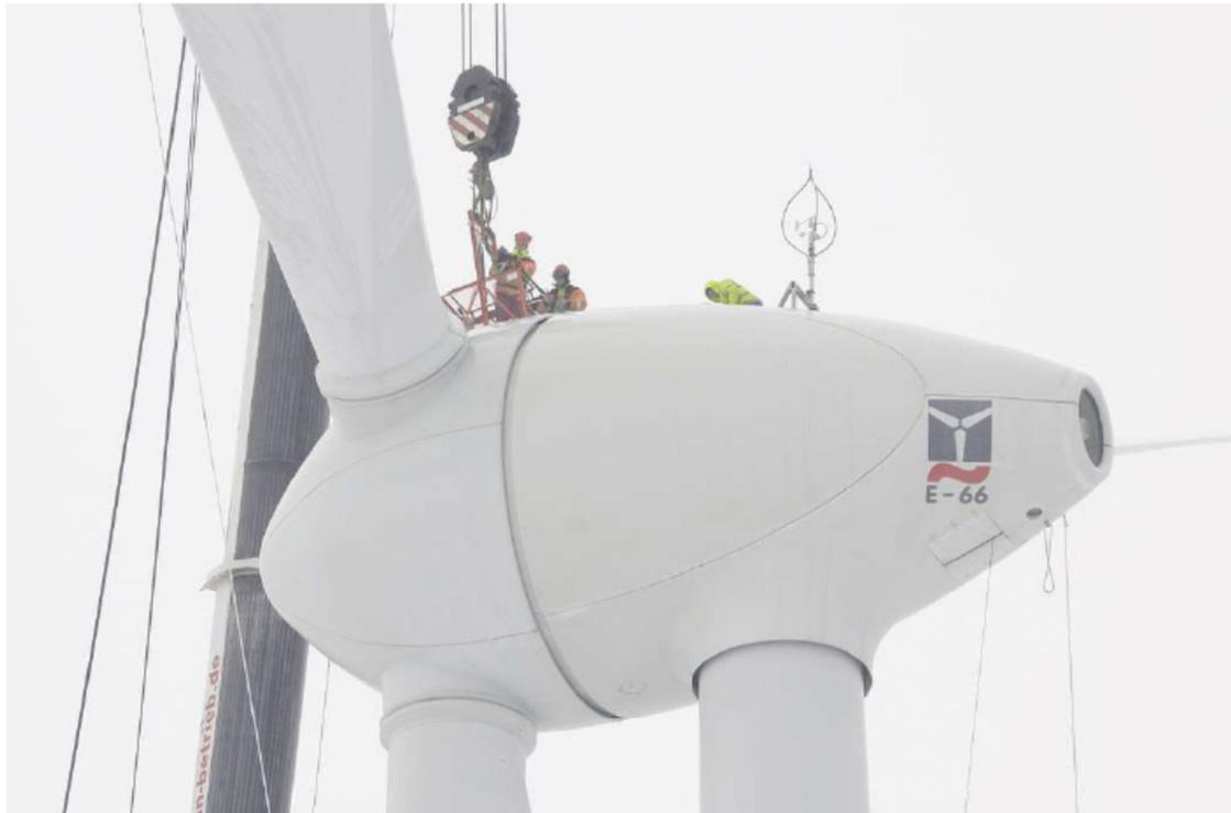
Kalter Arbeitsplatz in gut 65 Metern Höhe: Windrad-Experten hängen den Rotor mitsamt Nabe und Flügeln an den Kran-Haken.
