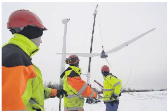
Erfolgreich gekippt: Horizontal wird der Rotor langsam am Boden abgesetzt.
